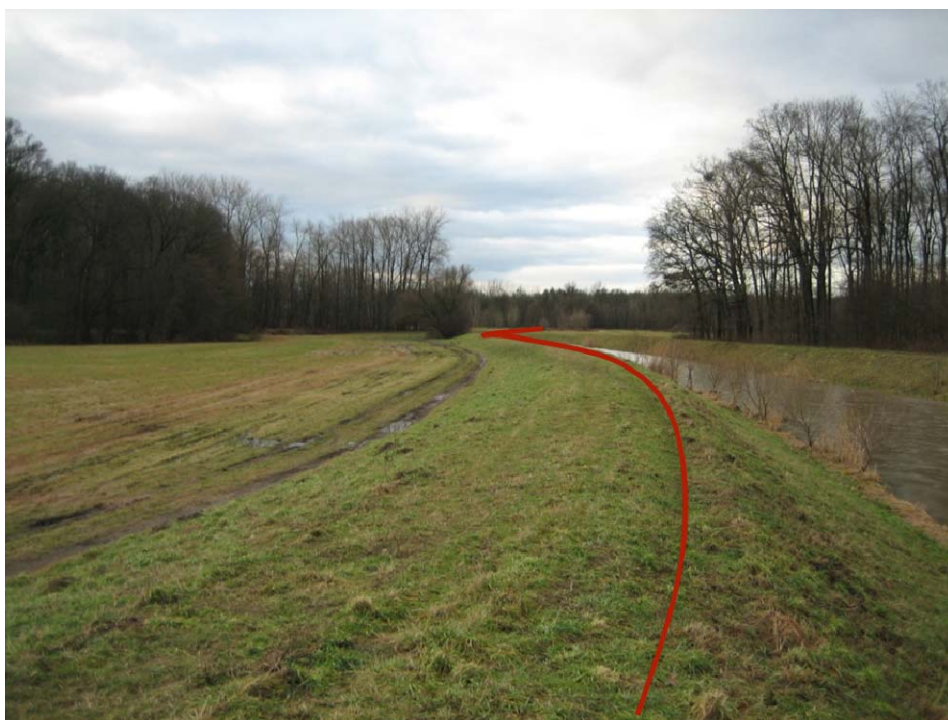
Obrázek 6 Povodňové hráze, bránící bezpečnému rozlivu v prostoru údolní nivy. Foto Z. Rettichová, 2010
